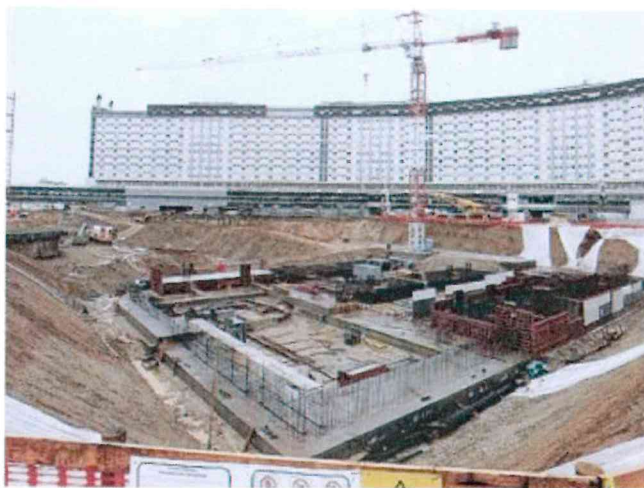
Cantiere all'ospedale: si erano verificate irregolarità, poi sanate.
